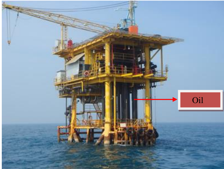
تصویر ۴ نمای لوله Riser
